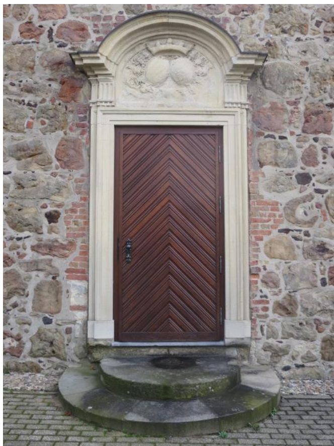
Portal an der Westseite der St.-Marien-Kirche (Bild von 2014)
